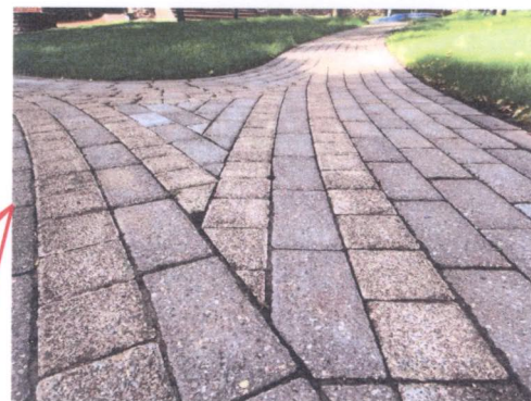
Покрытие дорожек и площадок для отдыха брусчаткой бетонной тротуарной
