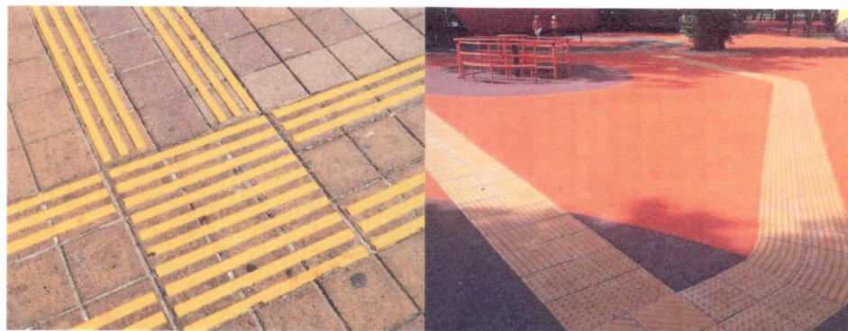
Устройство тактильной плитки
